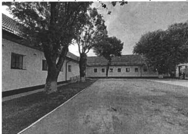
Corpul C1- reabilitat si modernizat- 2022
